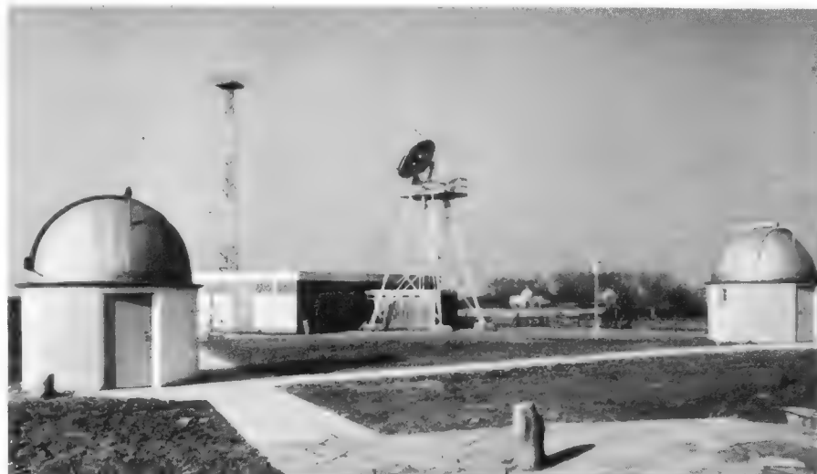
Bild 1. Institut für Satelliten- und Weltraumforschung Bochum. Im Hintergrund Stationsgebäude mit Parabolspiegelantenne, vorn rechts und links Beobachtungskuppeln für die optische Bahnverfolgung
