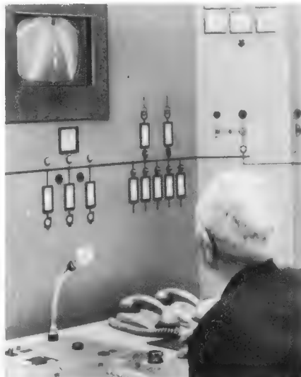
Bedienungspult der Fernseh-, Lautsprecher- und Lichtsignalanlagen des Rendsburger Straßentunnels
